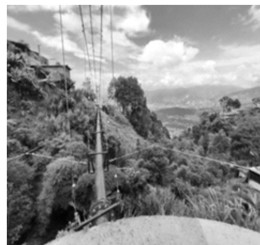
Alcantarillado Bello oriente Empresa publicas de Medellín conexiones por la vida
